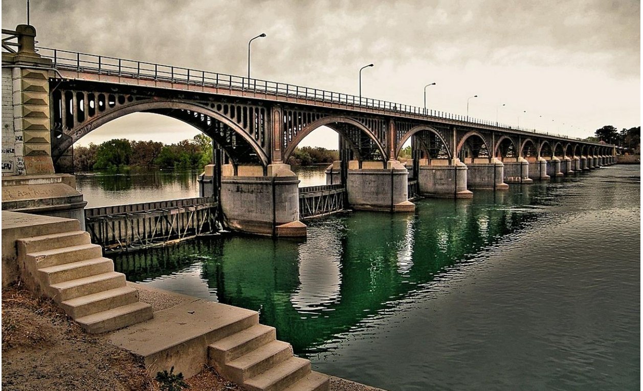
Vista del dique derivador Ing. Rodolfo Ballester, obra construida sobre el río Neuquén a 30 km aguas arriba de la ciudad de Neuquén. Fue diseñada a principios del siglo XX y habilitada una primera parte en el año 1918.
